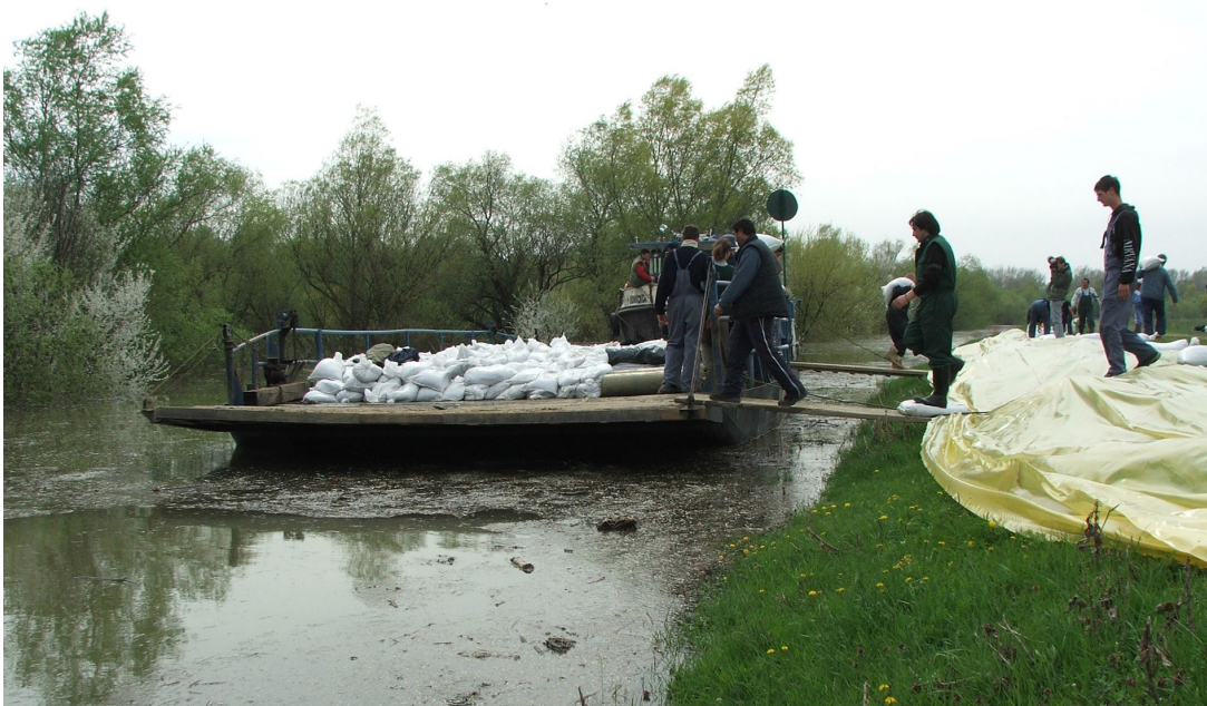
Skela je korištena za prenos džakova sa peskom za nadvišavanje nasipa na desnoj obali Tise 2006.
